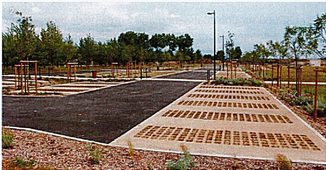
[1] Parking en dalles perméables végétalisées à Fréjus (© O2D)
