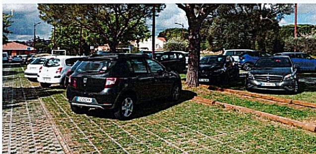
Un revêtement perméable pour infiltrer l'eau pluviale
