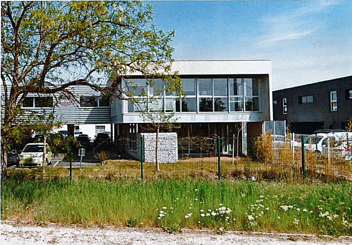
Exemple d'implantation sur un lot libre - ZA des Roquassier – Salon-de-Provence Recul paysager et aménagement d'un bassin de rétention en façade le long d'une voie principale, traitement architectural soigné, espaces de stationnement sous le bâtiment permettant de limiter les espaces imperméabilisés
