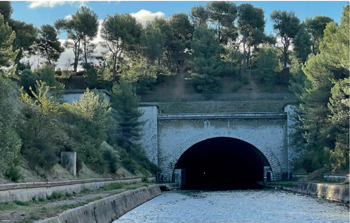
■ Entrée nord du tunnel, côté Maignane
